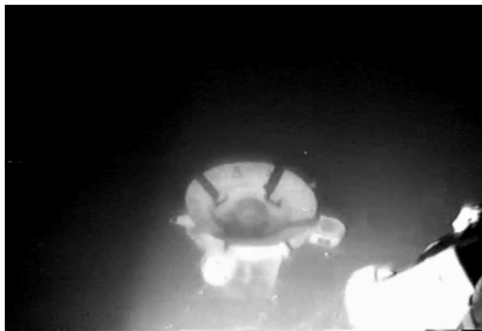
Figura 31. Equipamento de cabeça de poço.
