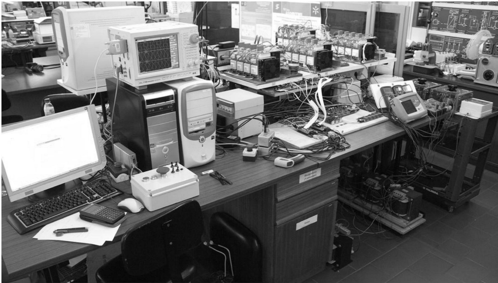
Fig. 6.15 Bancada do protótipo laboratorial do UPQC trifásico.
