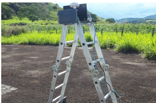
(c) RSU instalada na via.
