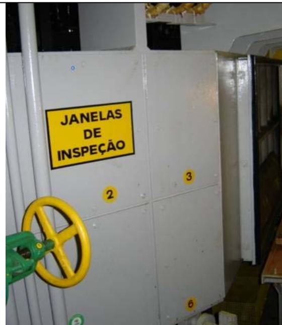
Figura 4.37 Janelas de inspeção.
