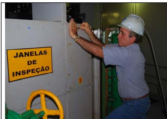
Figura 4.43 Abertura da janela de inspeção.
