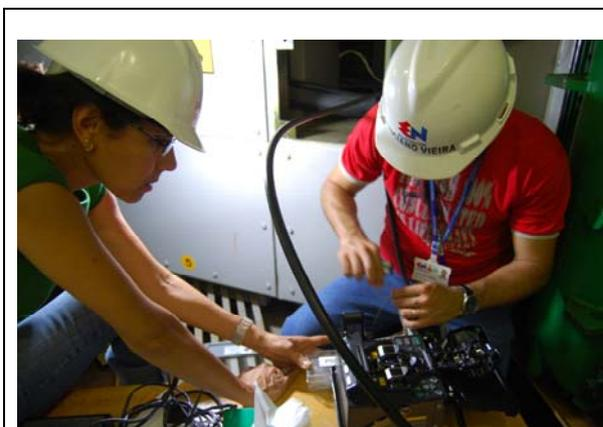
Figura 4.45 Realização de emenda dos sensores.
