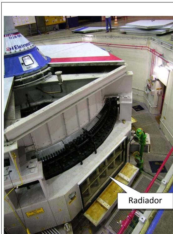
Figura 4.34 Local de instalação dos radiadores.
