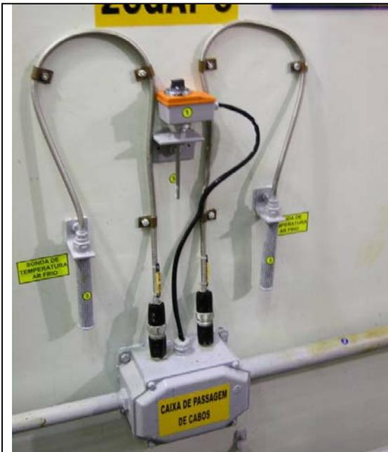
Figura 4.36 Sensores de temperatura para o ar frio que já passou pelos radiadores.
