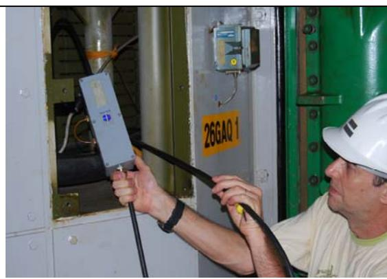
Figura 4.44 Retirada do sensor.
