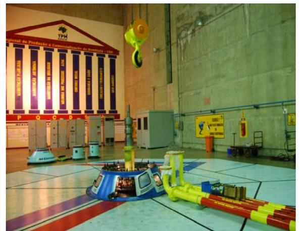
Figura 4.29 Máquina 5 desmontada.
