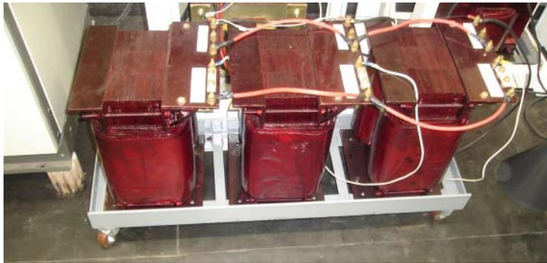
**Figura II-5: Transformadores Monofásicos Utilizados Para Inserir o Desequilíbrio de Seqüência Negativa no Sistema de Suprimento.**
