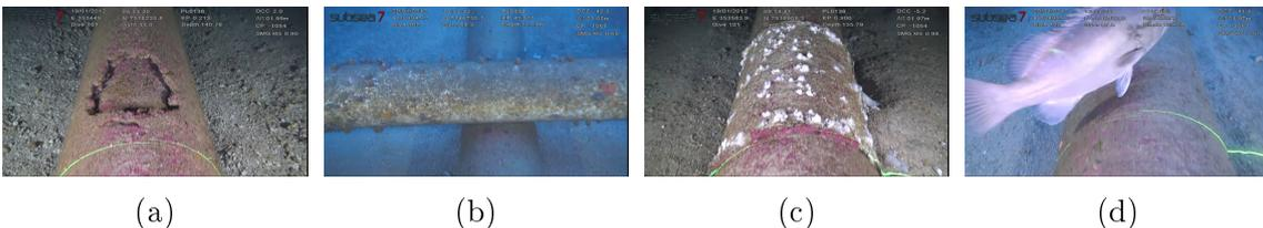
Figura 1.3: Exemplo de possíveis anomalias em seções dos dutos submarinos: (a) armadura externa danificada; (b) cruzamento entre dutos; (c) anodo de sacrifício; e (d) presença de peixe sobre o duto.
