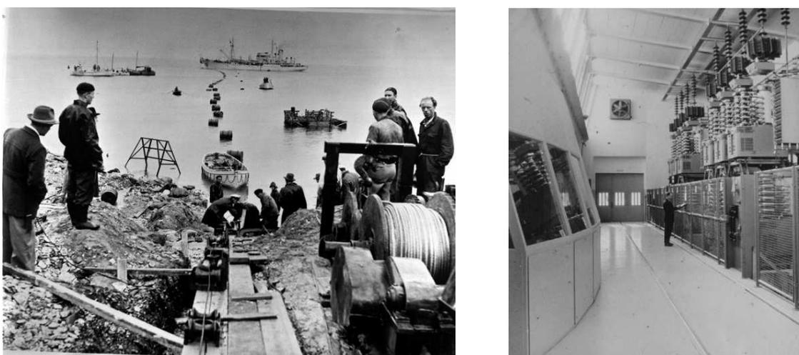
Figura 1 – Chegada dos cabos CC à ilha de Gotland – Pátio de válvulas de Gotland [23]
