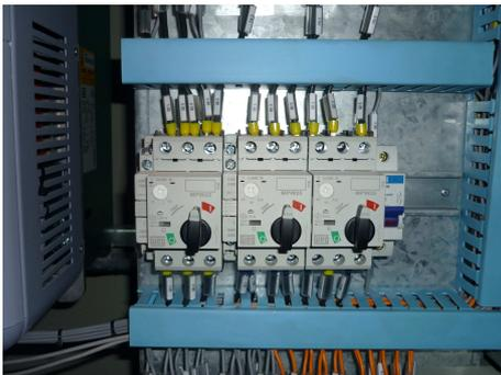
Figura 4.3: Disjuntor-Motor MPW25
