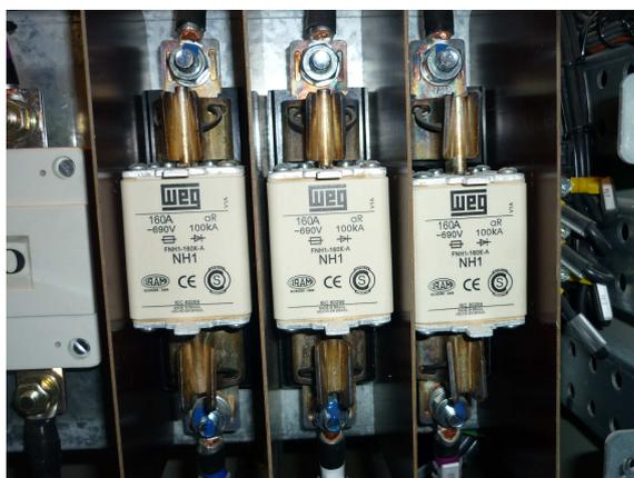
Figura 4.1: Fusíveis tipo faca -  $F1$ ,  $F2$  e  $F3$
