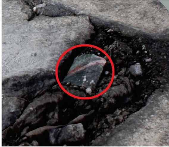
Figura 4.11: Resultado da presença do pequeno pedaço de papel na superfície.
