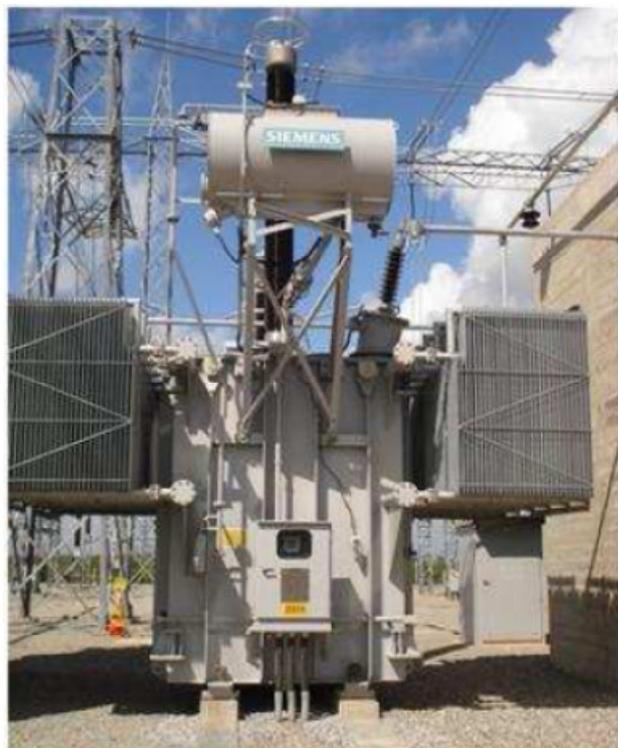
Figura 2.2 – Reator da Barra de 500 kV da SE Fortaleza II da CHESF [6]
