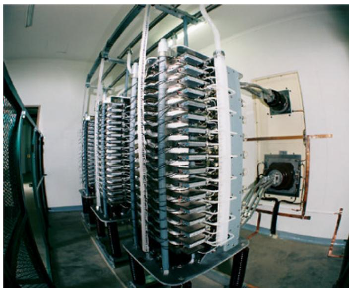
Figura 9 – Válvula Tiristora de 15 kV de um TCR<sup>12</sup>
