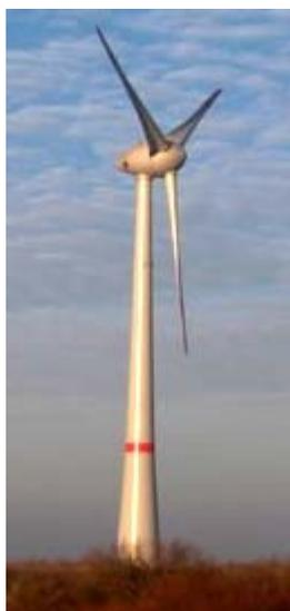
Fig. 3: Turbina eólica de alta potência - Enercon E-126 com potência de 7MW e diâmetro de 126m, [16].
