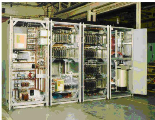
Fig. 28: Cicloconversor Refrigerado a água com 5,6 MW.
