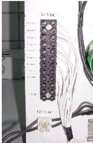
Figura 4.29: Pontos de alimentação 127 V da rede elétrica e 24 VDC via CLP.
