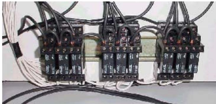
Figura 4.30: Relés de chaveamento para acionamento das lâmpadas.
